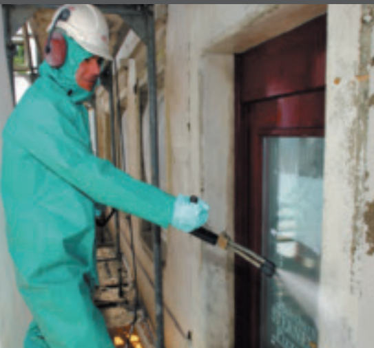
1. Eine sorgfältige Vorbereitung und perfekte Reinigung des Untergrunds sind die Basis für einen hochwertigen Anstrich.
